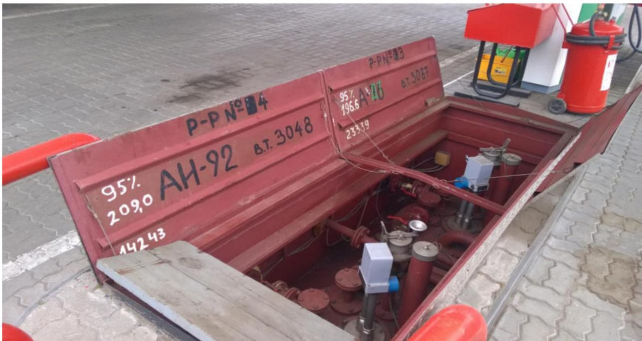
Рис.1 Фото смонтированных УД на резервуаре
